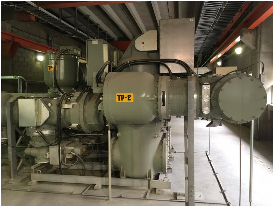
Figura 2.5. Cuchilla aislada en SF 6 , planta de Cooperativa la Cruz Azul planta Hidalgo
