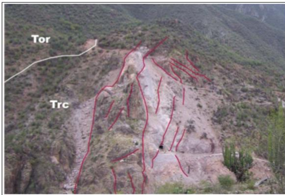
Figura 7. Zona del eje de la cortina, se aprecia la serie de bloques colapsados y deslizados, que fueron brechados durante el colapso. CFE (2010).
