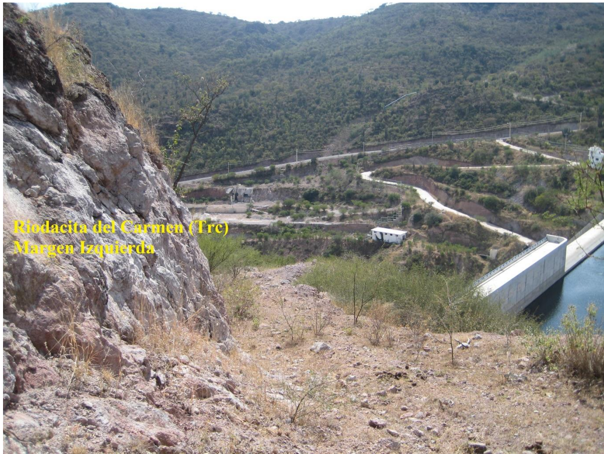
Figura 9. Margen Izquierda de la presa “El Realito” (enero 2017).
