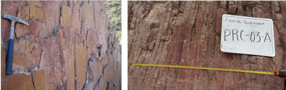
Figura 13. Ignimbrita El Órgano margen derecha de la Presa El Realito (septiembre 2016).
