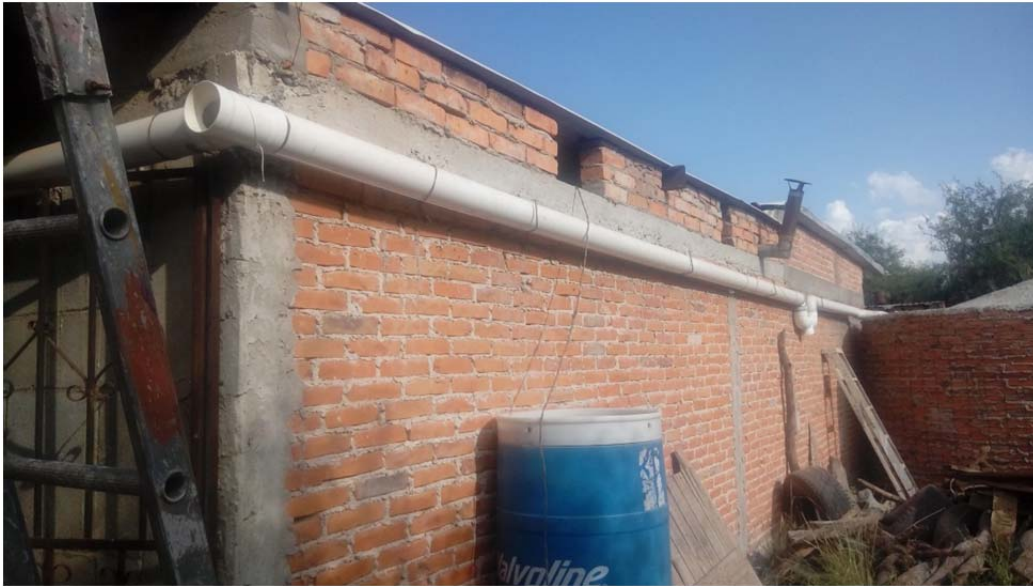
Figura 3-24 Líneas de conducción instaladas.
