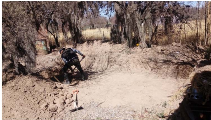
Figura 3-26 Lugar donde se va a construir el de humedal.
