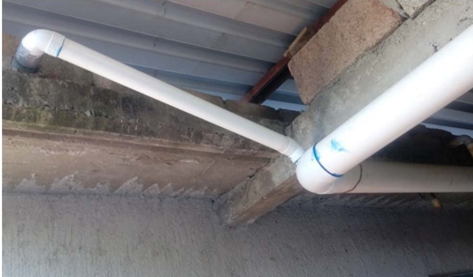
Figura 3-22 Recorrido de líneas de conducción.
