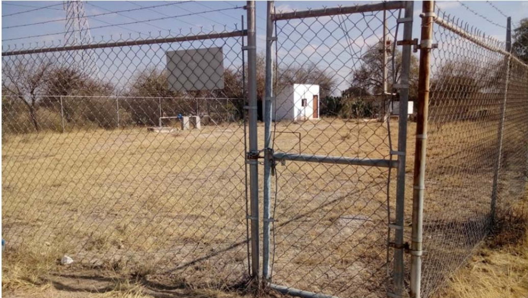
Figura 3-5 Pozo de agua existente
