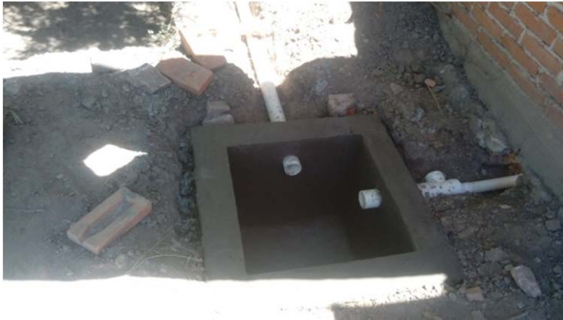
Figura 3-27 Construcción de trampa de grasas.
