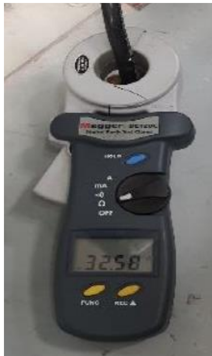
Figura 5.2 Medición de resistencia a uno de los electrodos de tierra instalados en el área de soldadoras.
