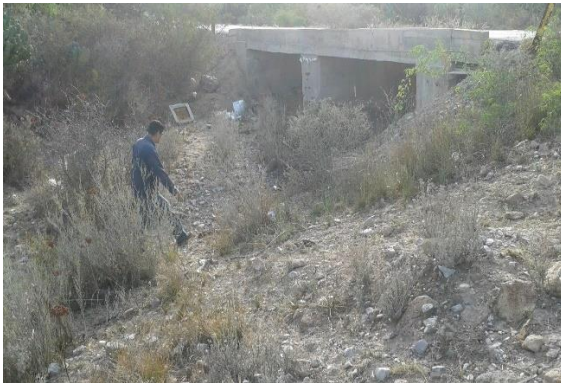
Figura 12. Puente construido a base de residuos de actividades mineras.
