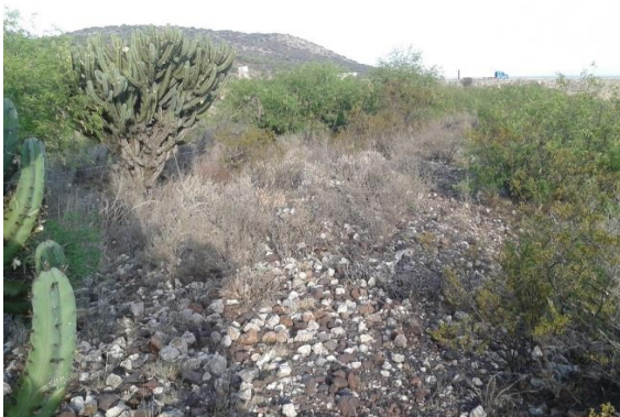
Figura 14. Terraplén construido a base de residuos de las actividades mineras
