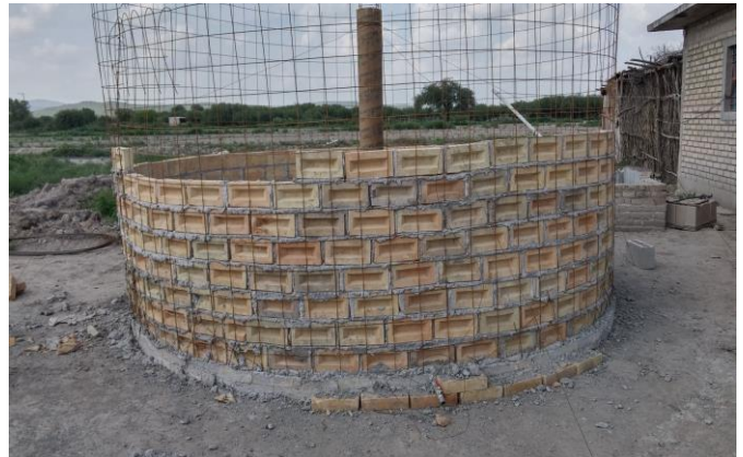
Fotografías 1 y 2. Construcción de muro capuchino
