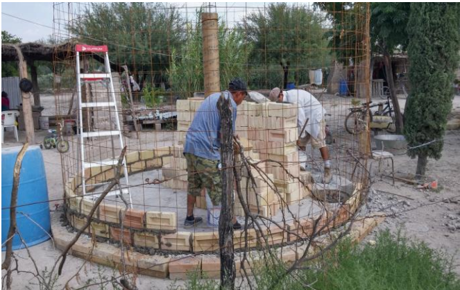
Fotografías 1 y 2. Construcción de muro capuchino
