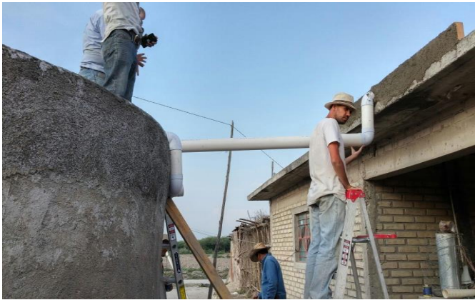
Fotografía 7. Instalación de SCALL
