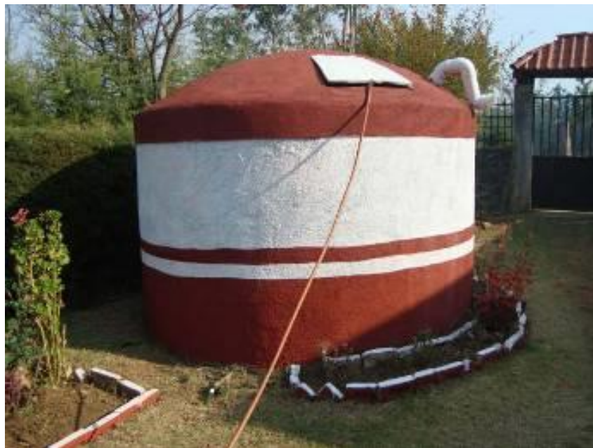
Figura 1.54 Cisterna de 11 m 3 instalada en Pátzcuaro, Michoacán, México. Fuente: Manual de sistemas de captación de agua de lluvia a nivel vivienda. IMTA 2015
