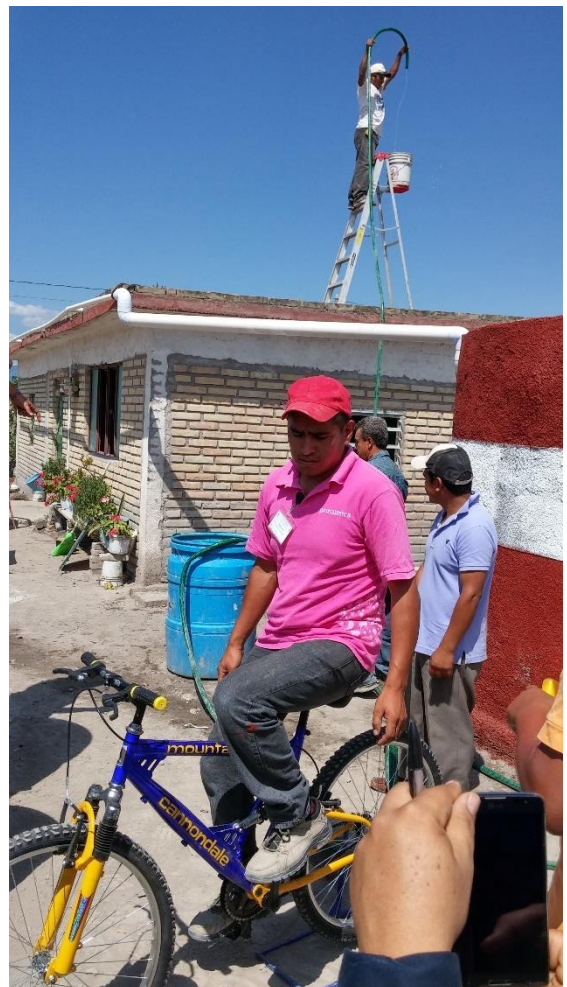
Figura 4.10 Prueba de bombeo
