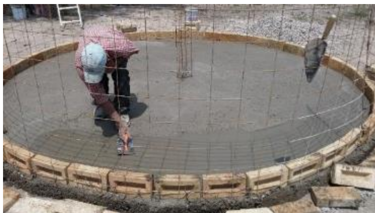
Figura 3.21 Construcción cisterna
