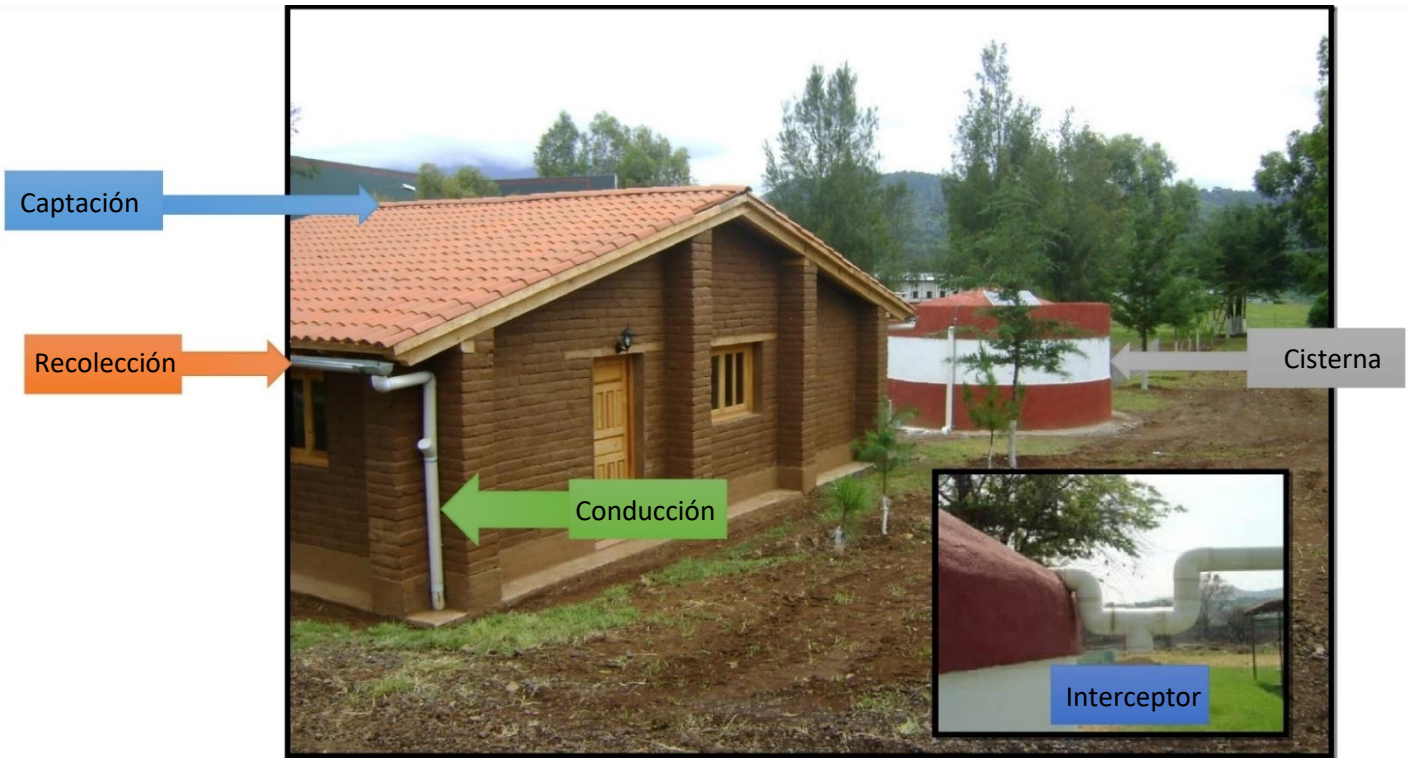
Figura 1.52 SCALL a nivel vivienda. Quiroga, Michoacán Fuente: Manual de sistemas de captación de agua de lluvia nivel vivienda. IMTA 2015
