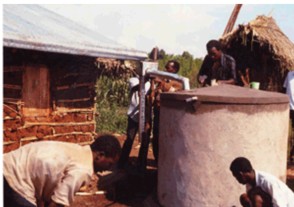
Figura 1.41 Cisterna de Ferrocemento, Kenia
