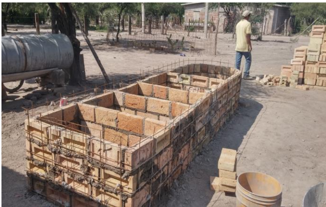
Fotografías 3 y 4. Construcción de lavadero ecológico
