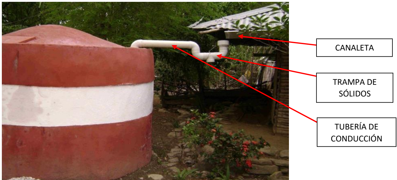
Figura 2.4 Sistema de conducción de agua de lluvia
