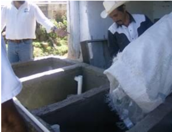
Figura 2.9 Celdas con anillos de PET para fijar las bacterias
