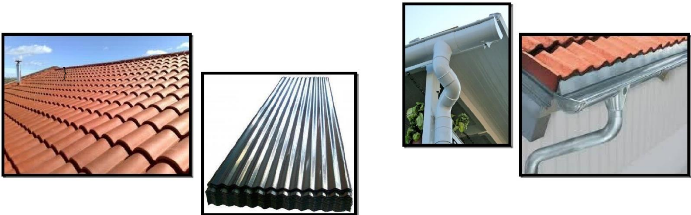
Figura 1.53 Techo para captación y tubería para conducción Fuente: Manual de sistemas de captación de agua de lluvia nivel vivienda. IMTA 2015
