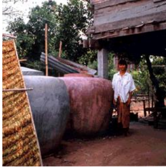
Figura 1.47 Colector de agua de lluvia, Tailandia
