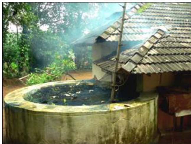
Figura 1.44 SCALL a nivel vivienda para uso en Nueva Delhi, India
