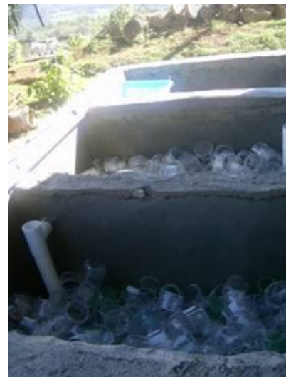
Figura 2.9 Celdas con anillos de PET para fijar las bacterias
