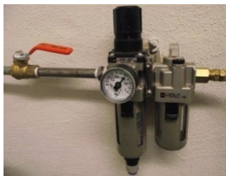
Fig. E. 2 Sistema de aire seco.
