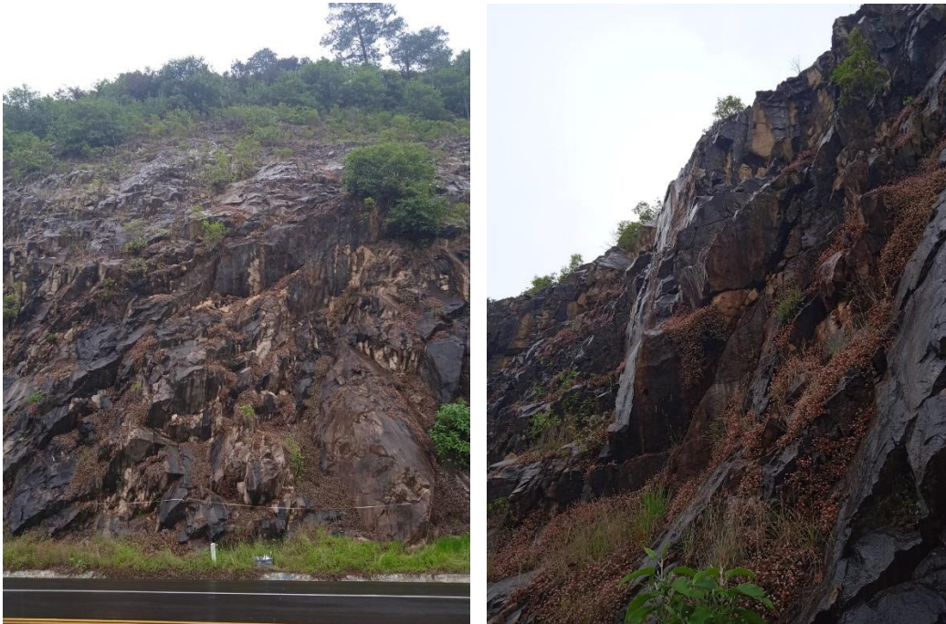
Figura 4.31 y 4.32: Talud de La Autopista
