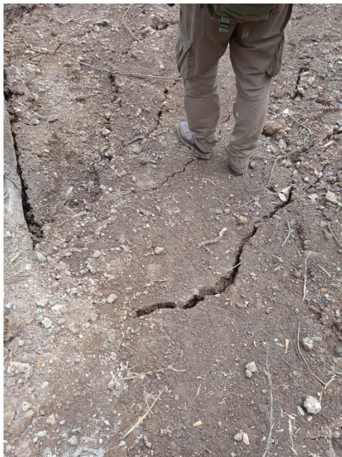
Figura 4.26, 4.27 y 4.28: Grietas de tensión en el talud de La Aurora
