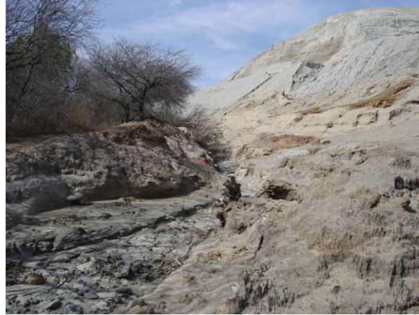
Fotografía 2.2 Evidencias de erosión por escorrentías a los costados de las presas de jales, en el distrito minero de Santa María de la Paz, S.L.P. México (Briones 2005).
