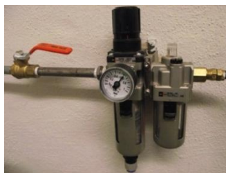
Fig. A. 2 Sistema de aire seco.
