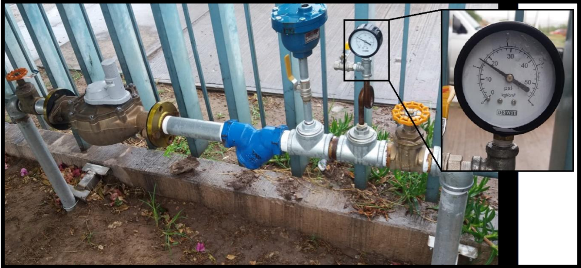
Figura. 7 Lectura de manómetros en medidores de cada usuario de la red.
