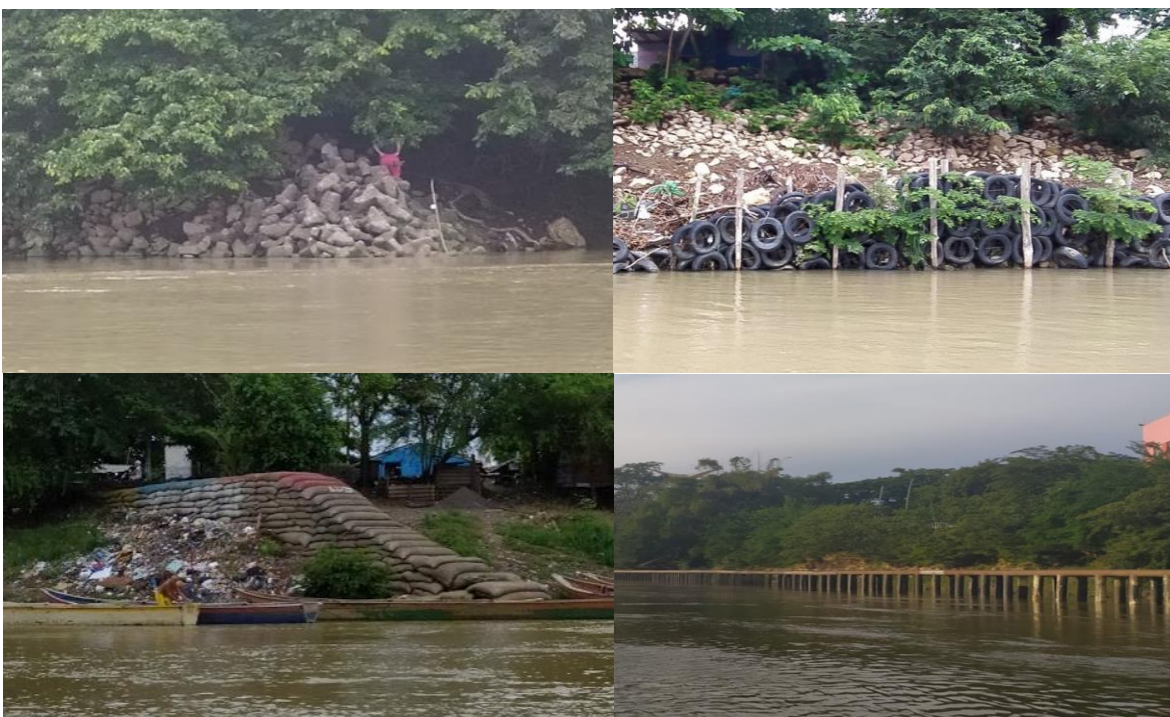
Figura 41. Obras de protección sobre el río Sinú.
