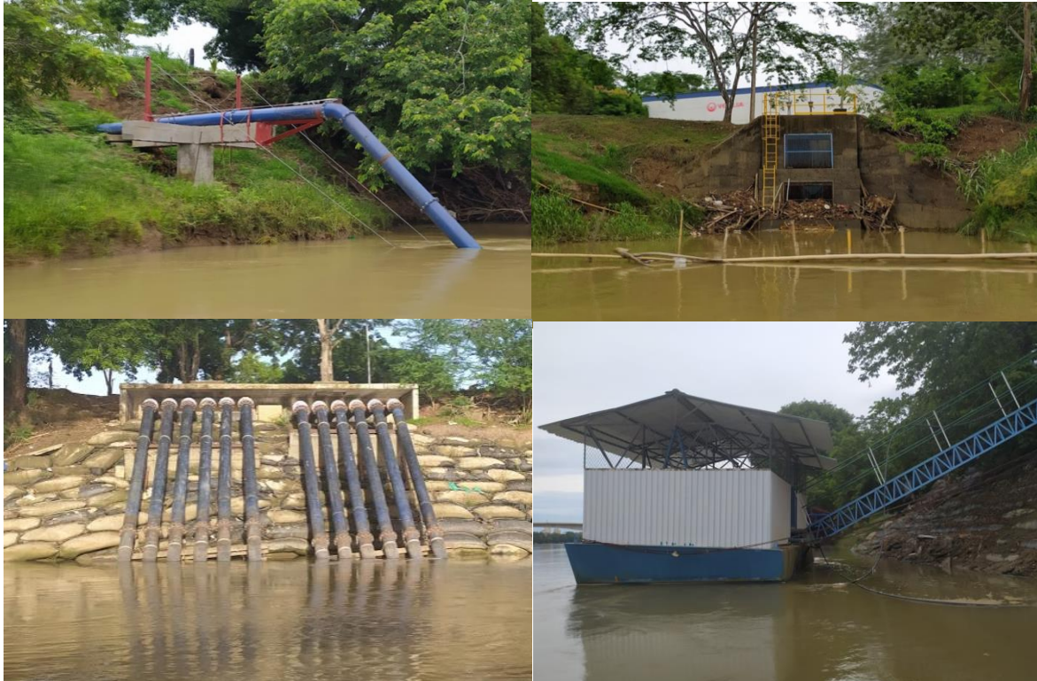
Figura 38. Obras de toma y descarga sobre el río Sinú.
