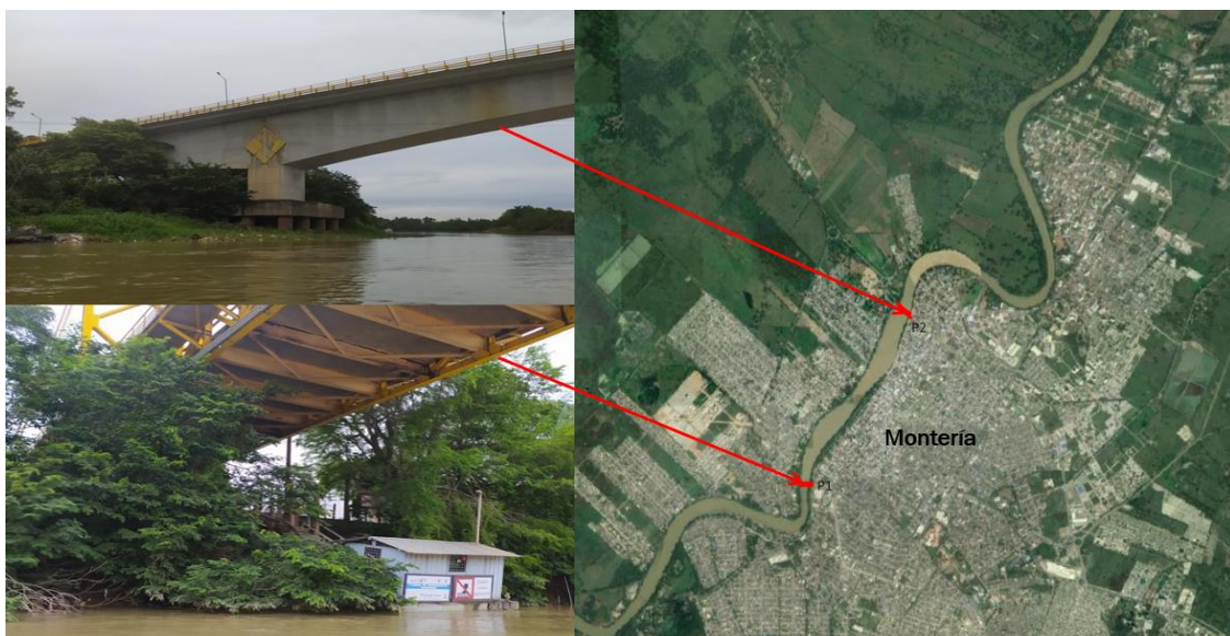
Figura 39. Estructuras de cruce sobre el río Sinú.
