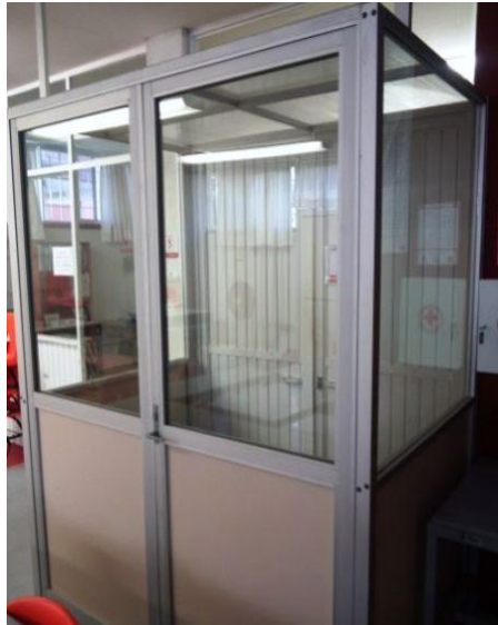
Figura 3.7 Cuarto de medición independiente con doble puerta de acceso.
