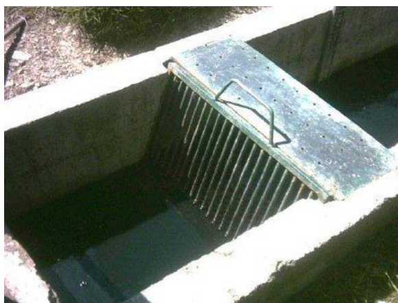
Figura 4.5 Rejilla media con lámina perforada para escurrimiento del material extraído. Fuente: William Antonio Lozano-Rivas, 2009.
