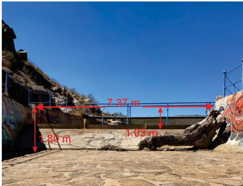
Figura 1.9. Vertedor en la margen derecha.
