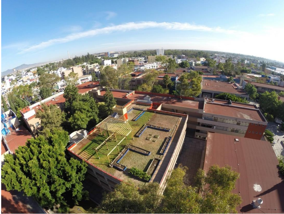
Figura 4. 15. Uni techo en la Facultad de Ingeniería. (Facultad de Ingeniería, 2018).
