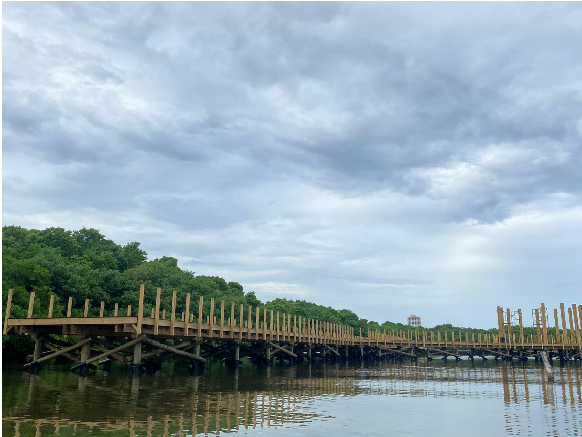
Figura 4. 10. Proceso constructivo del Ecoparque etapa 1.
