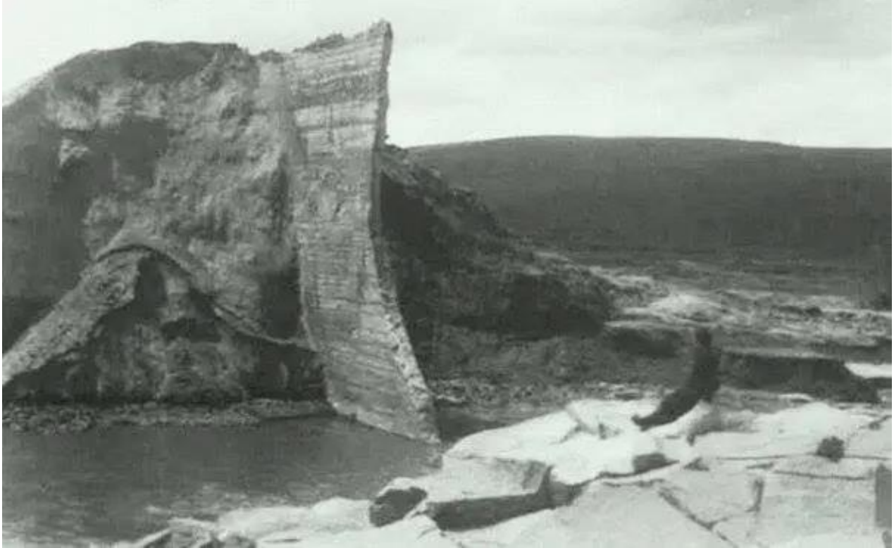
Figura 1. 6. Colapso de la presa.
