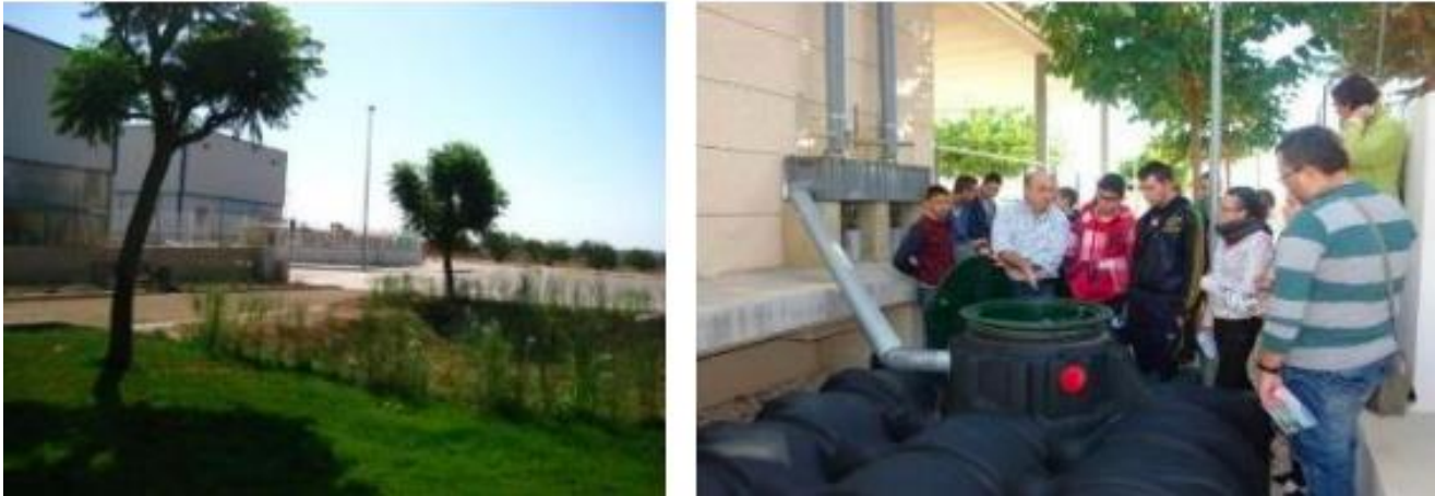
Figura 4. 8. SUDS en Benaguasli (Valencia). (GreenBlueManagement).
