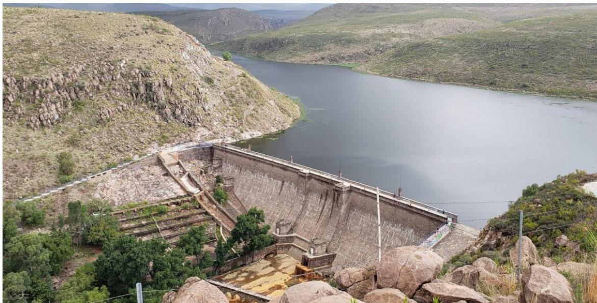
Figura 1-17 Presa San José. Fuente: (Camacho, 2021)
