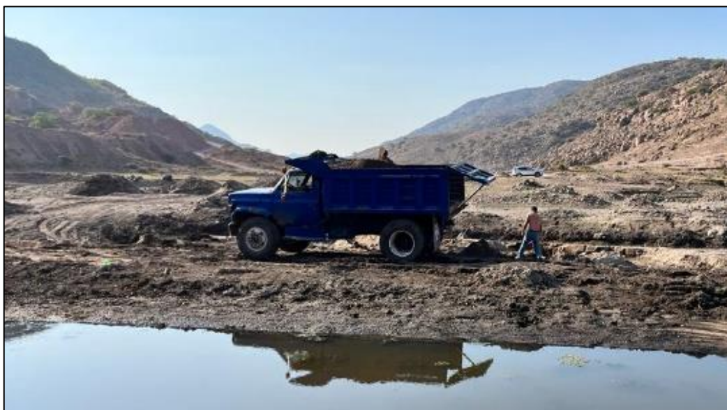
Figura 51. Camiones cargados de tierra lama de la presa San José.
