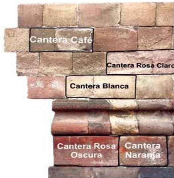
Figura 1. Pared norte del templo del Carmen donde se muestran las 5 diferentes canteras en su construcción. Obtenida de "El rescate del patrimonio cultural pétreo de San Luis Potosí" por López Doncel, 2015.
