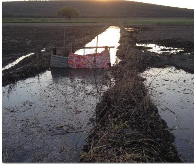
Figura 13 Canal secundario con pérdidas de agua por infiltraciones
