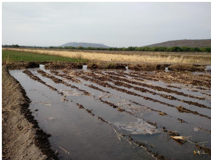
Figura 17 Tomas de agua construidas sobre los bordos de un canal terciario
