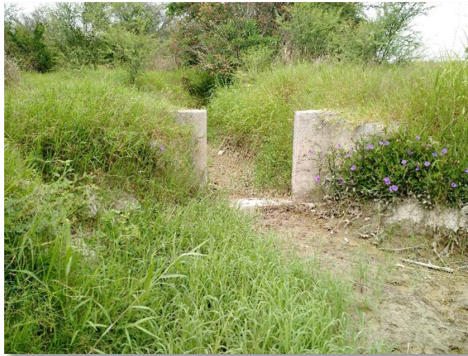
Figura 15 Estructura reguladora de flujo de agua en canal secundario
