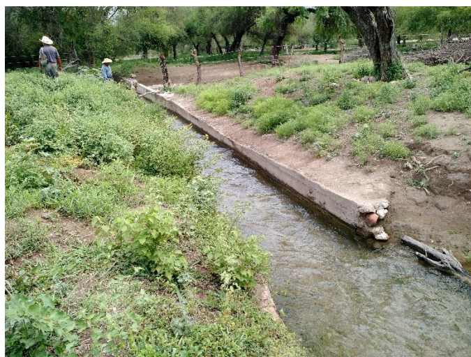
Figura 31 Recorrido sobre el canal principal para la ubicación de tomas laterales
