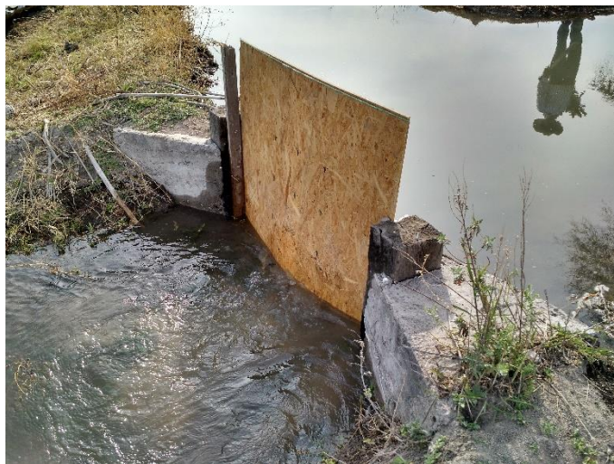
Figura 16 Toma y compuerta sobre el canal principal
