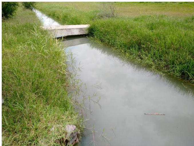
Figura 11 Canal principal excavado en tierra en parte sur del regadío
