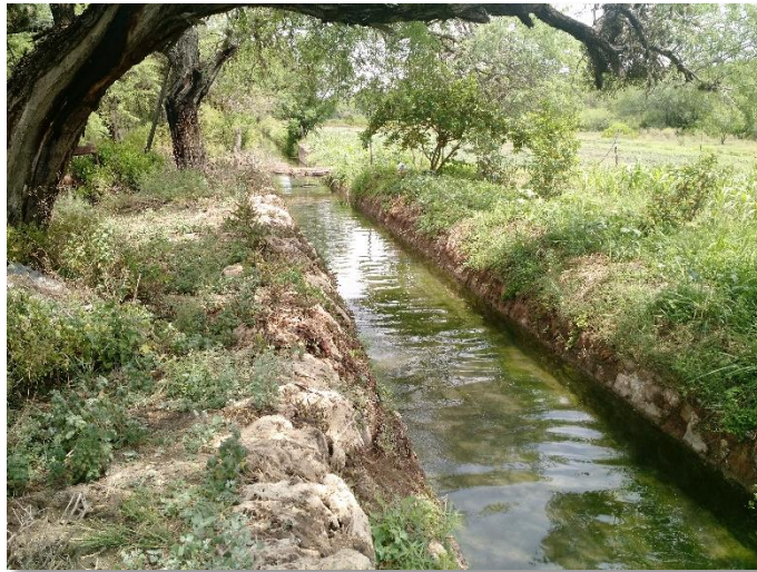
Figura 10 Tramo del canal principal construido de cal y canto
