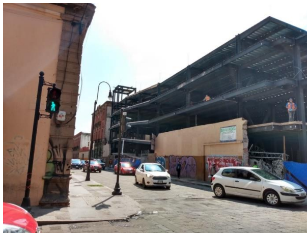
Figura 10: Estacionamiento público, aún en fase de construcción al año 2021. Hacia la fecha actual (2023) ya había terminado su construcción.
