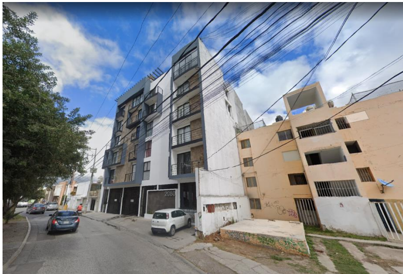
Figura 16: Edificio Veinte80, situado sobre la avenida Prolongación Muñoz en la colonia Jacarandas, en un entorno de viviendas de tipo tradicional con evidente deterioro.
