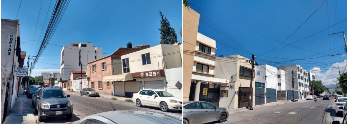
Figura 7: Casas de máximo dos niveles con antigüedad considerable en la misma manzana que la Torre Acarta (izquierda) y condominios modernos de reciente construcción sobre la misma calle, algunos metros al norte del caso de estudio (derecha).
