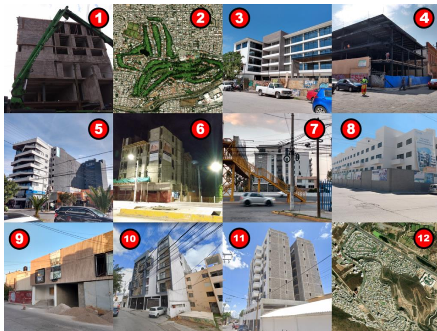
Figura 5: Fotografías de los casos de estudio tomadas en campo (edificación en vista isométrica) o por imágenes aéreas de Google Earth (vista desde arriba).
