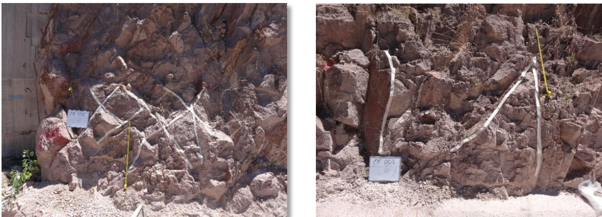
Figura 10.- Talud ER-001 en el cual se observan 3 grupos de familias en la Ignimbrita el Órgano.
