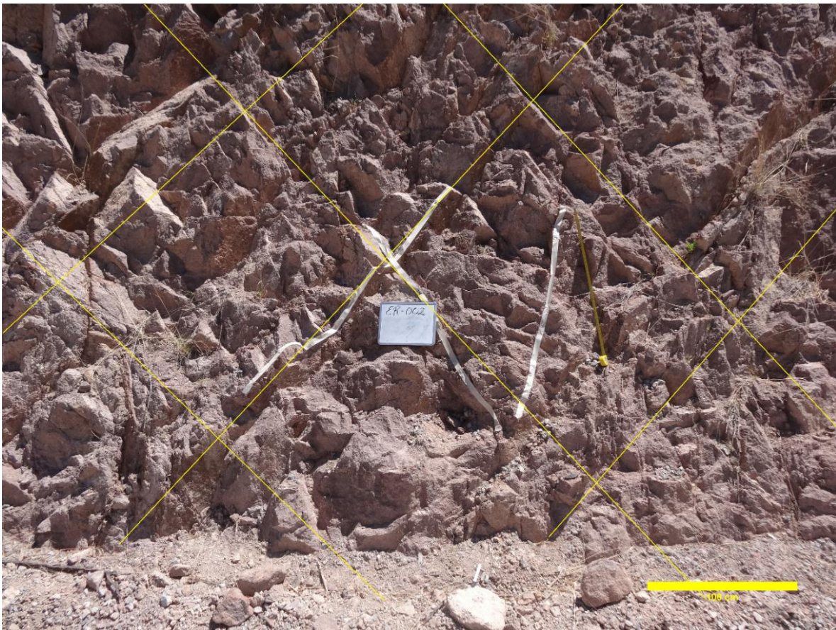
Figura 43.- Talud ER-002 escalado a 1m donde se ven líneas guías para la medición de las discontinuidades.
