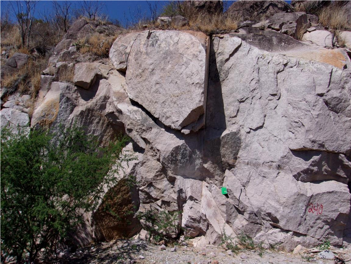
Figura 35.- Cuña de 4.5 m de alto ubicada en la carretera Tierra Nueva- El Realito, la discontinuidad de la derecha es casi vertical y perpendicular al frente del corte.
