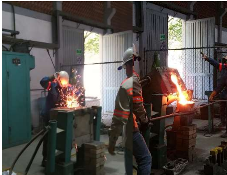
Figura 12. Fusión y vaciado del acero.
