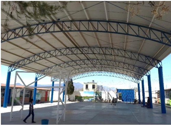
Figura 6.4 Cubierta de lámina galvanizada del patio principal.
