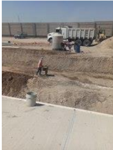
Figura 24. Compactación del terreno.
