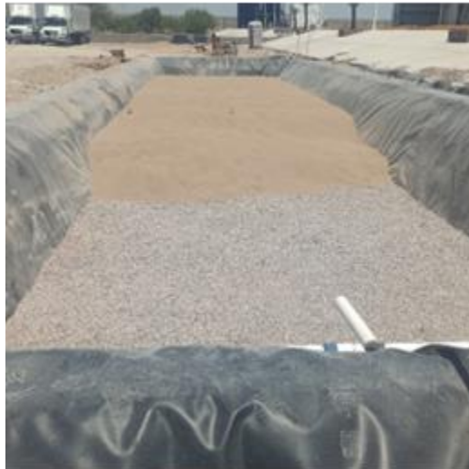
Figura 27. Colocación de cama arena sílice, grava \frac{3}{8} y posteriormente grava \frac{3}{4} .
