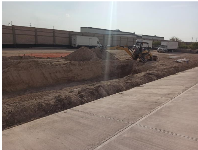
Figura 22. Excavación del terreno.
