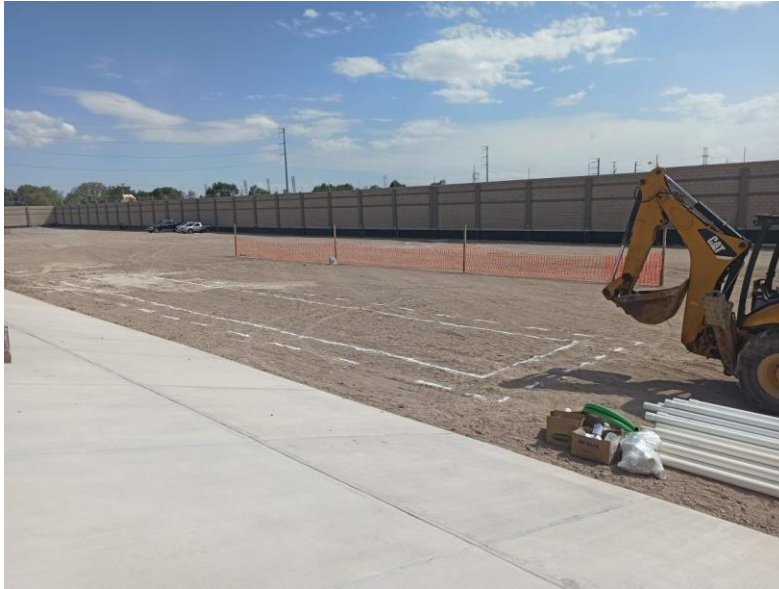
Figura 21. Trazo y nivelación del terreno.
