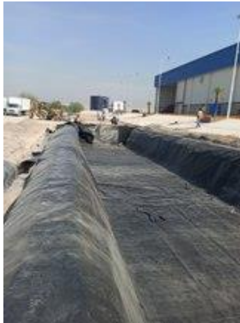
Figura 26. Impermeabilización del humedal.
