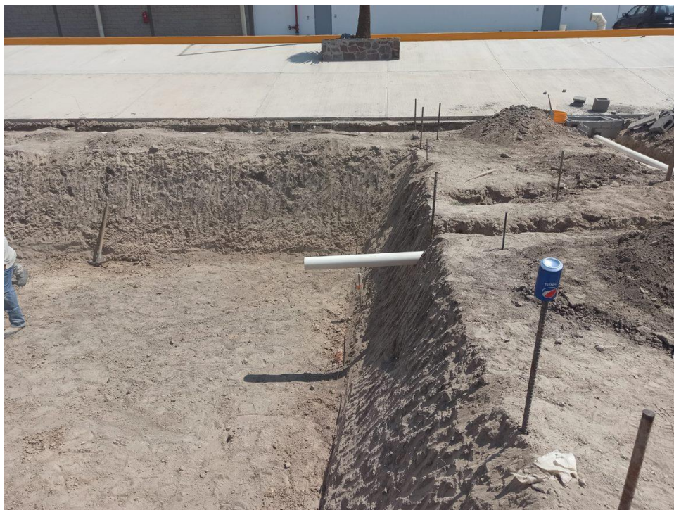
Figura 25. Colocación de tubería de entrada.
