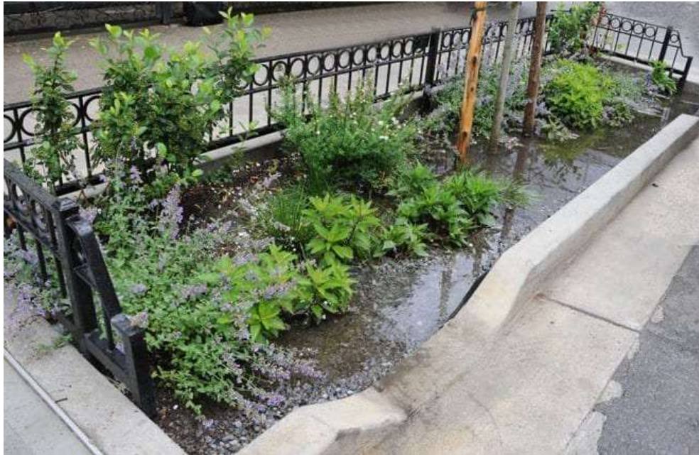
Figura 3-8 - Jardín de lluvia en área de contención junto a una banqueta, ilustración de Ecological Landscape Alliance
