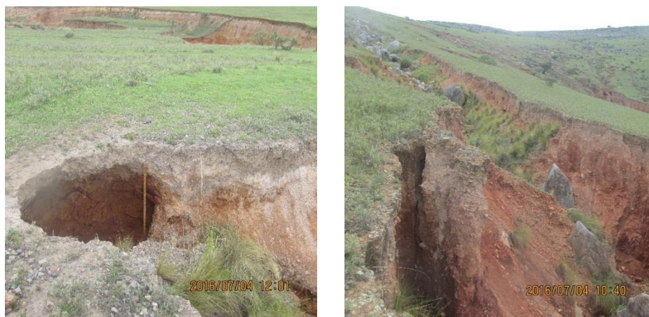
Figura 27. Fotografías de cárcavas asociadas a deslizamiento, en A) se puede observar el montículo de suelo colapsado en la cabeza de cárcava con clave GH21, en B) colapso masivo del suelo en la pared de una cárcava (indicado por el suelo con la misma cubierta vegetal)
