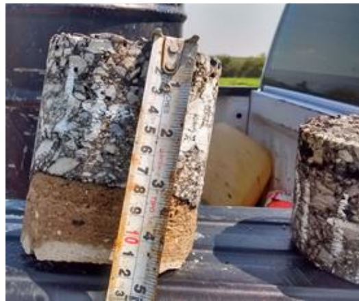
Figura 20.- Detalle de muestra extraída de sondeo: CASAA, carpeta asfáltica y porción de base cementada
