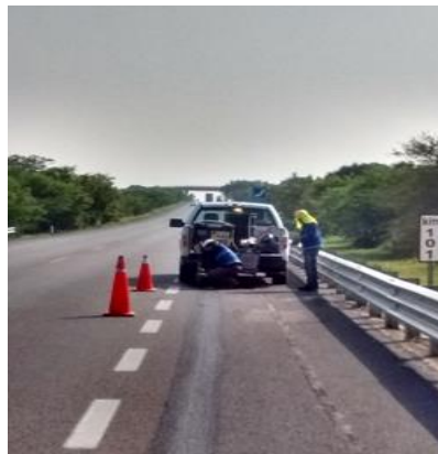
Figura 18.- Realización de calas y sondeos en el acotamiento del km 101+000 del Libramiento Ciudad Valles-Tamuín.
