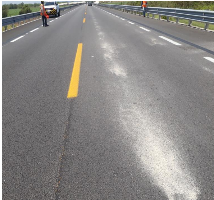
Figura 6.- Estado actual del Pavimento Fisuras Longitudinales, Transversales y desprendimiento de finos, Segmento 2 del km 100+000 al km 118+640.
