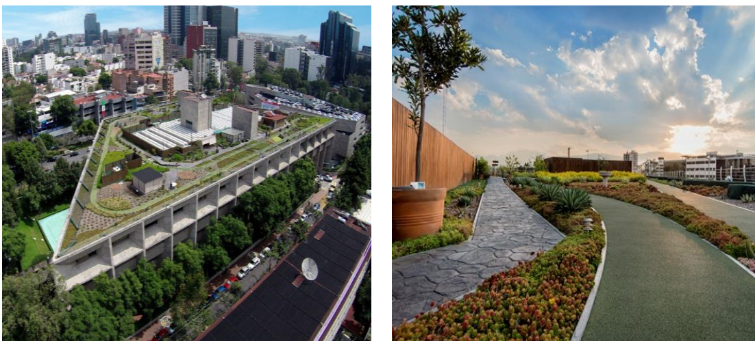
Figura 15. Cubierta Verde instalada en Infonavit en CDMX. Fuente: Landezine International Landscape Award.
