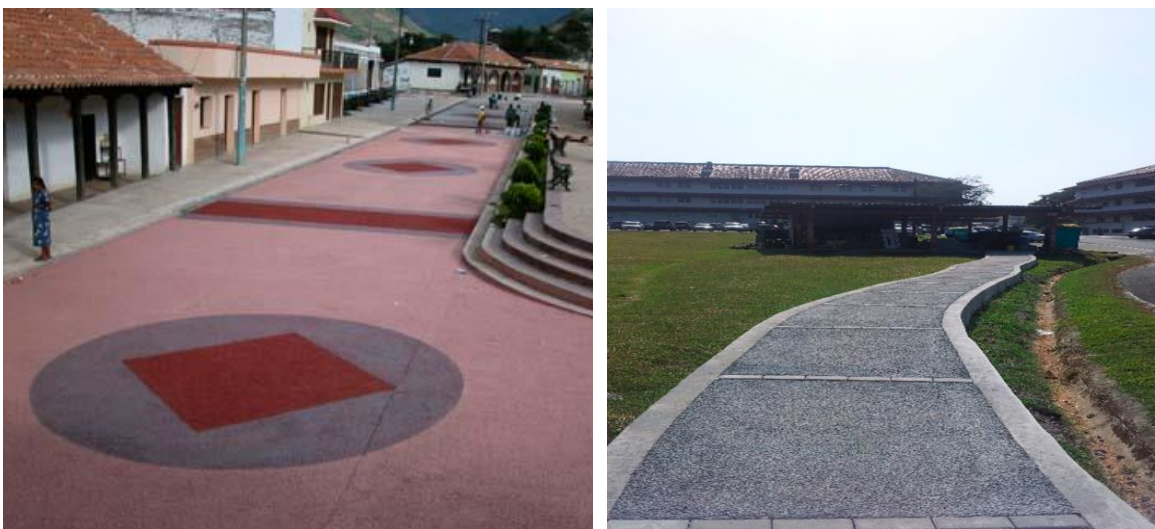
Figura 17. Pavimentos permeables instalados. Fuente: verdeceto.com.mx.
