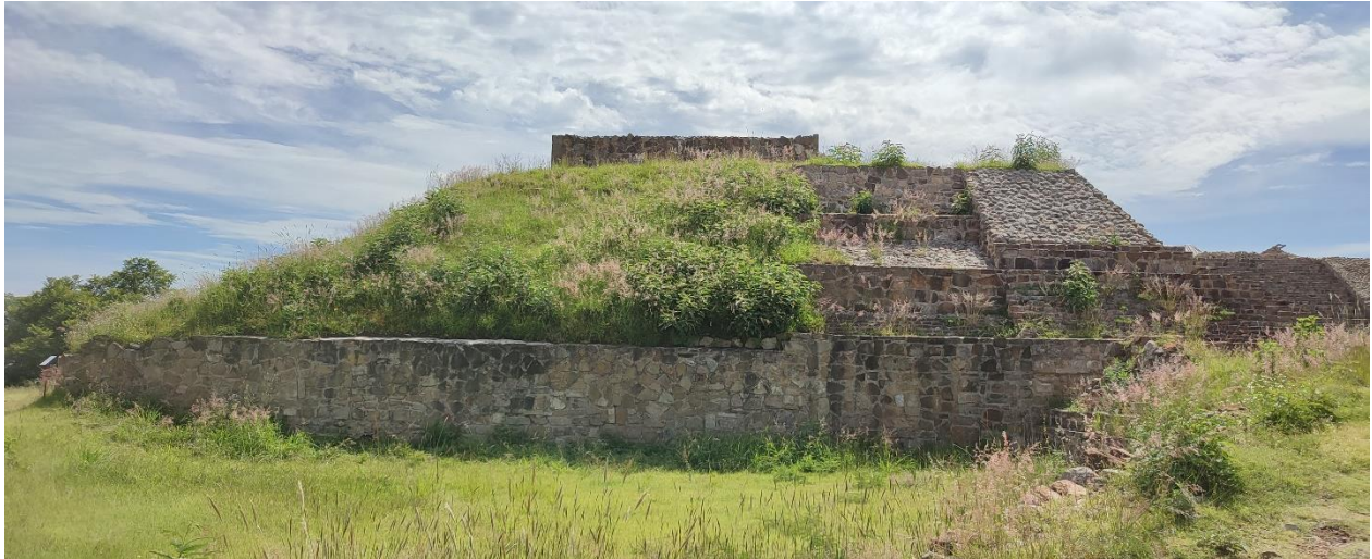
Figura 29. Fachada Oeste del edificio D, en la zona arqueológica de Monte Albán.
