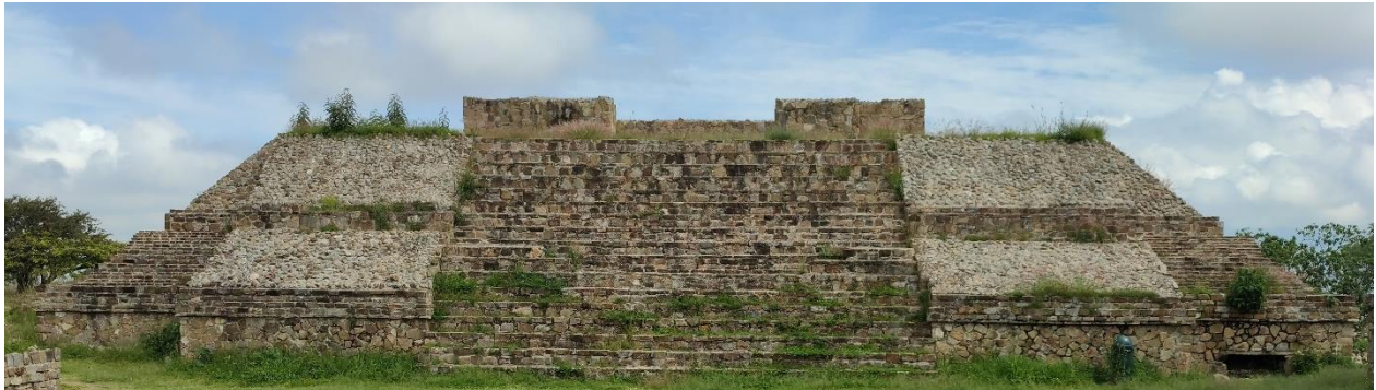
Figura 16. Fachada Sur del edificio D, en la zona arqueológica de Monte Albán.
