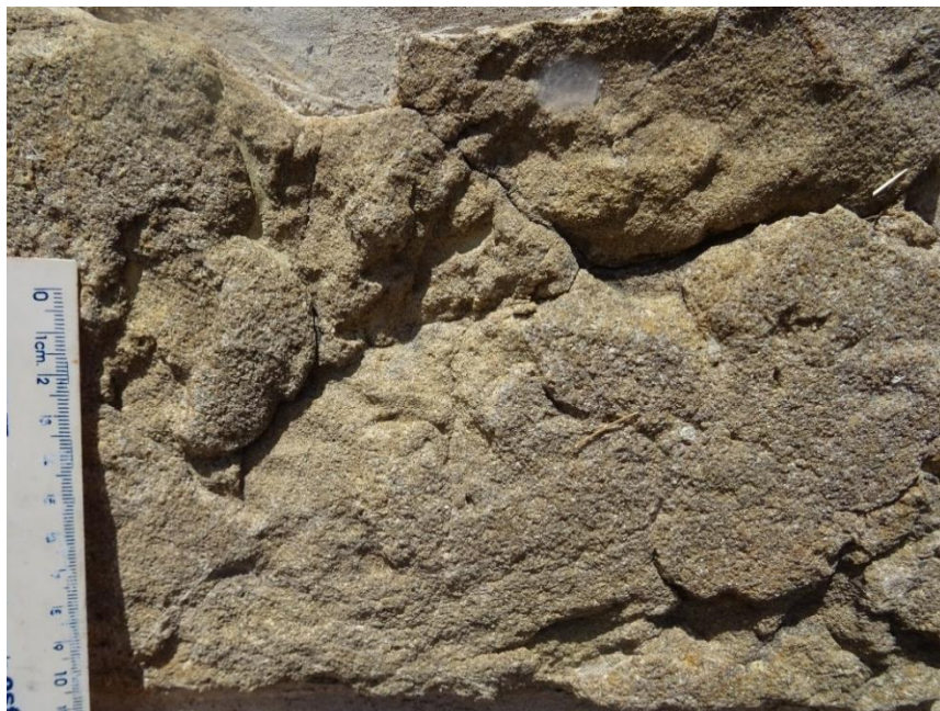
Figura 9. Desintegración granular presentada en una de las rocas que forman parte del edificio D en la zona arqueológica de Monte Alban.
