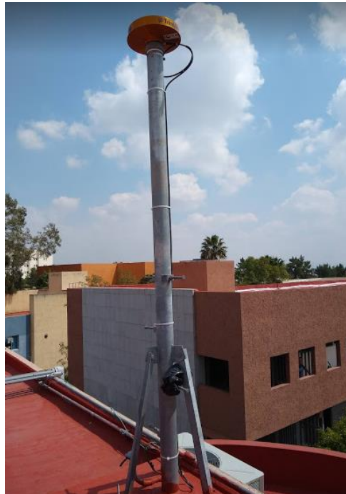
Figura 62. Antena GNSS choke ring. Lugar de instalación, edificio Departamento de física, UASLP.
