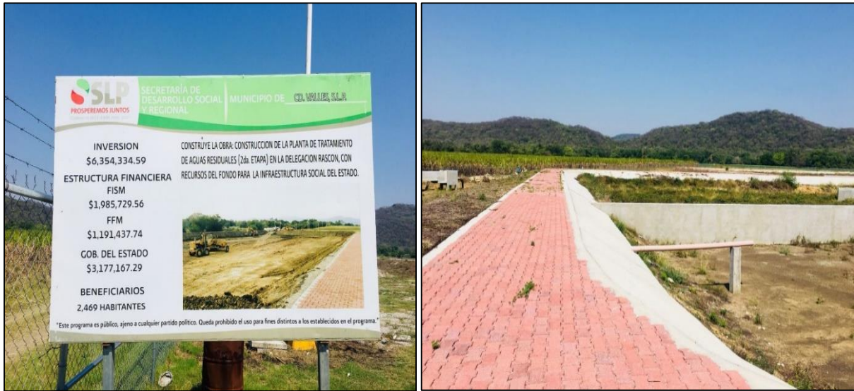
Figura 3.23. Planta de tratamiento de aguas residuales localidad Rascón.
