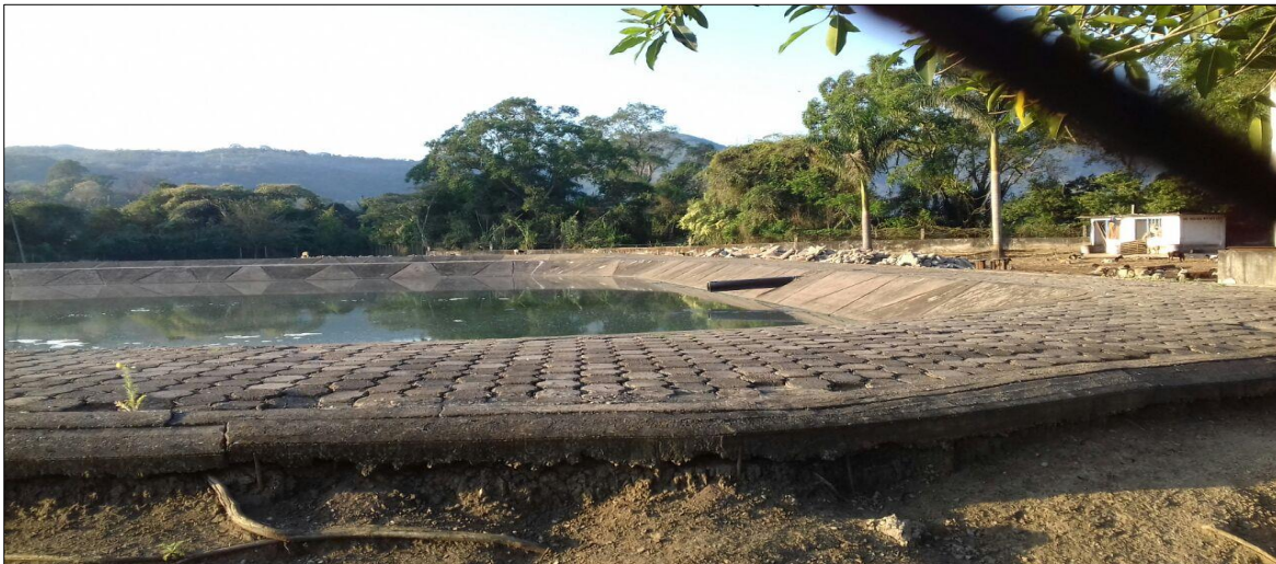
Figura 3.19. Planta de tratamiento de aguas residuales de la localidad de Tamasopo.
