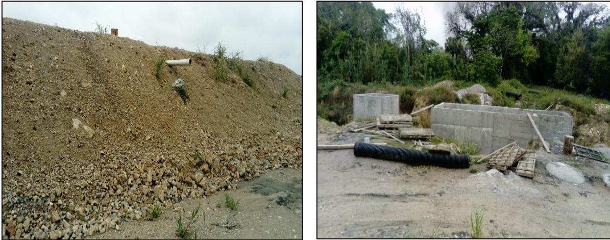
Figura 3.21. Segunda PTAR ingenio Alianza Popular, en construcción.
