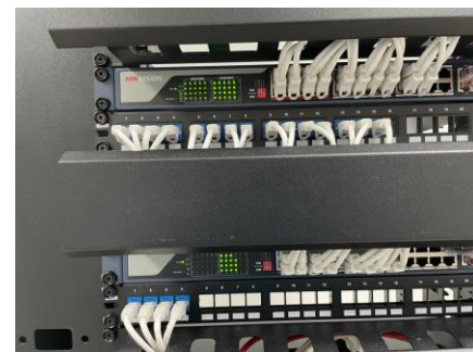
Figura 6ª Estandarización de procesos. Switch de 48 puertos para red automatizada de alto rendimiento
