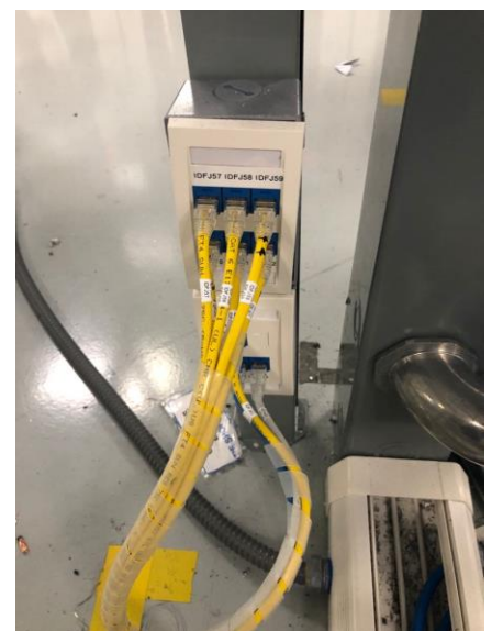
Figura 12ª Estandarización de procesos. Migración a Mini Jack categoría 6 para alta velocidad en segmentación de red
