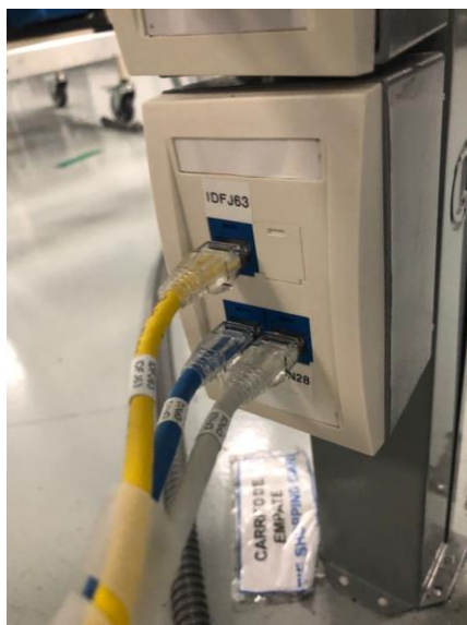
Figura 10ª Estandarización de procesos. Segmentación por cables de colores para determinar la potencia que necesita
