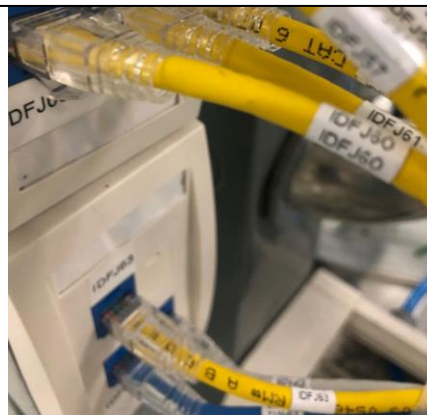
Figura 11ª Estandarización de procesos. Elaboración de Cables Patch categoría 6 para tráfico pesado
