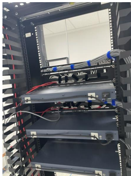
Figura 5ª Estandarización de procesos. Instalación de rack y cableado de red general
