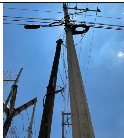
Figura 18ª Refuerzo en capital humano. Tendido de fibra óptica en conexión de punto a punto sin perder velocidad
