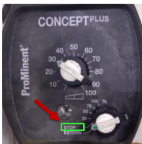
Figura 34. Bomba de la BDA; perilla inferior en posición STOP #1
