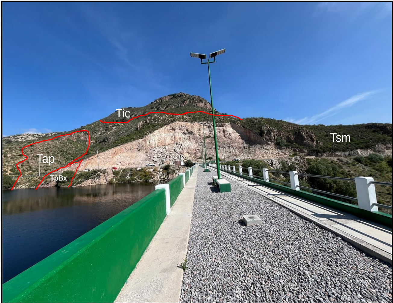
Figura 12. Domo riolítico “mesa El Panal”, fotografía exhibiendo las divisiones de las 3 unidades de rocas volcánicas existentes en el talud izquierdo de la cortina de la presa Gonzalo N. Santos y la brecha tectónica, (TpBx).
