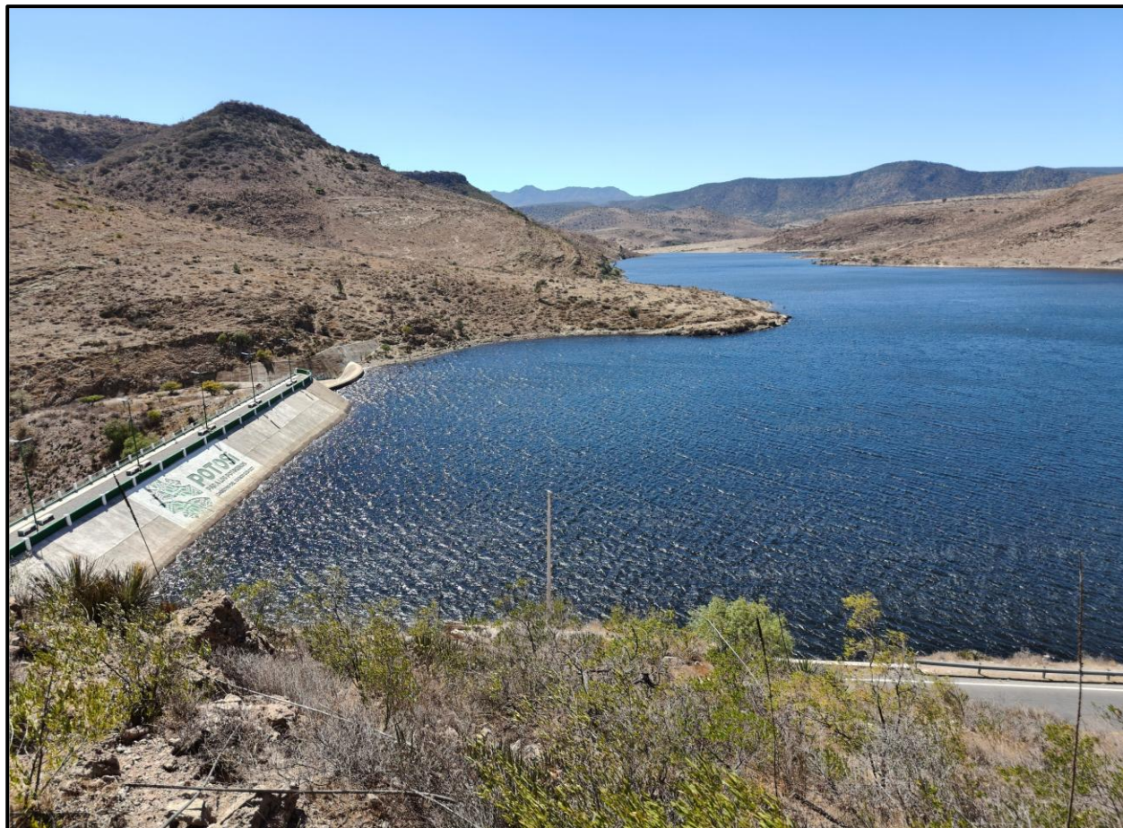
Figura 4. Presa Gonzalo N. Santos, mostrando una de las 3 presas que conforman la red de distribución de agua para la ciudad de San Luis Potosí, además controla el flujo de agua en el Río Santiago que cruza por la misma ciudad.
