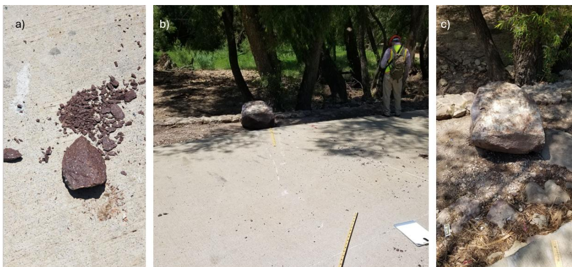
Figura 33. Evidencia del bloque caído en la ladera izquierda registrada durante la visita de campo del 3 de junio de 2025.
