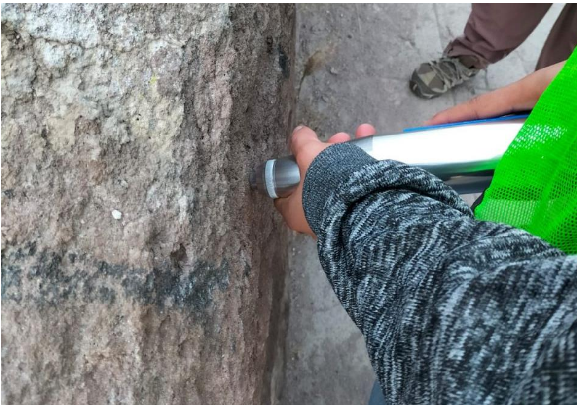
Figura 14. Medición de la resistencia a la compresión del macizo rocoso mediante el ensayo de martillo de rebote tipo Schmidt (modelo N). En esta toma se observa que la medición se realiza de forma horizontal.
