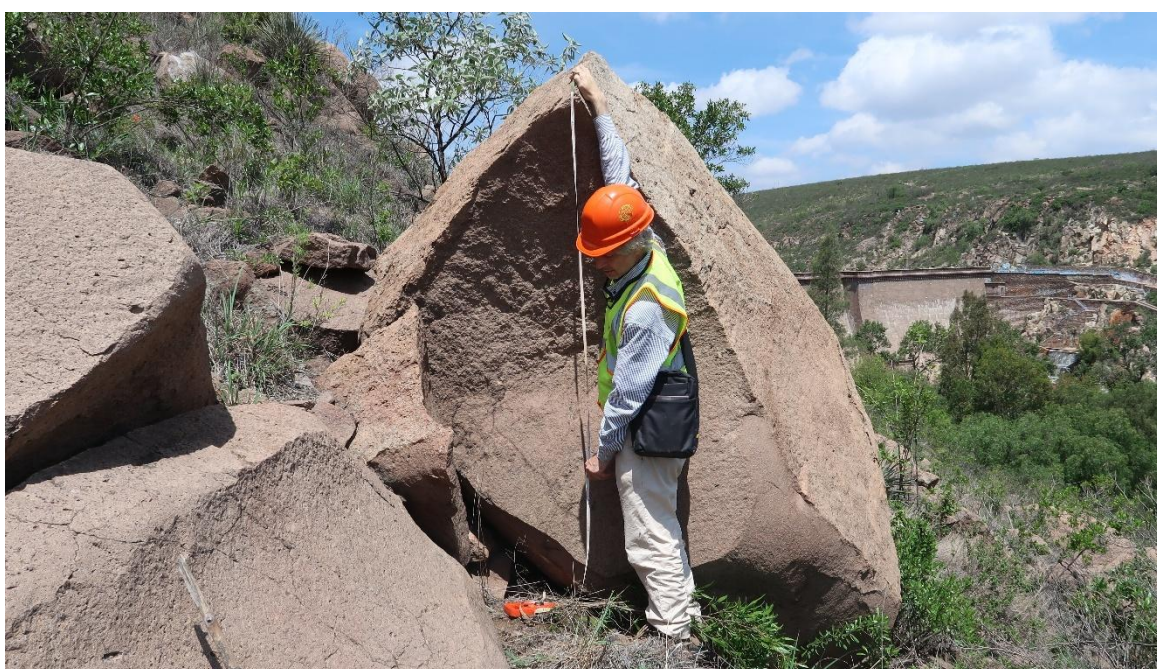
Figura 11. Medición de las dimensiones de un bloque inestable en la ladera derecha de la Presa San José mediante cinta métrica.
