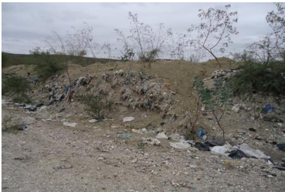
Figura 6.9 Condiciones actuales del talud de la celda de contención de residuos en el sitio de estudio.
