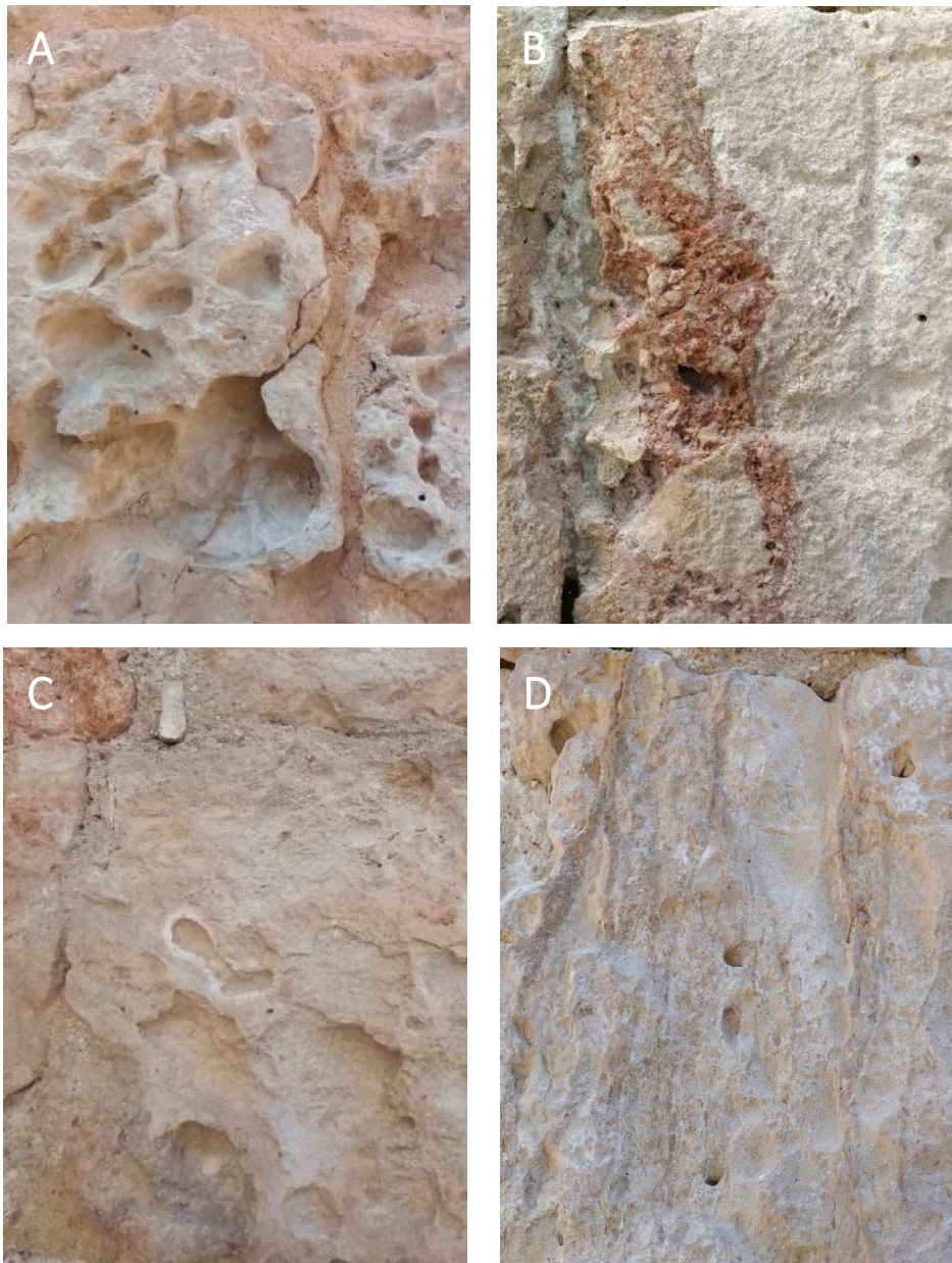
Figura 15. A) Alveolización en roca caliza, B) Erosión diferencial de caliza y brecha calcárea con clastos, C) Alveolo con velo salino a su alrededor y D) Perforaciones de avispas.
