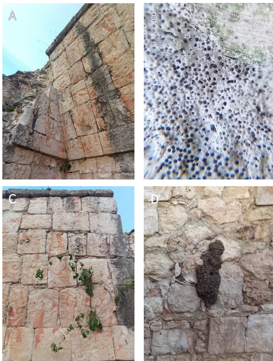
Figura 17. A) Escurrimiento con biopelícula color gris oscuro en la bóveda, B) Biopelícula vista en una lupa de 30 aumentos, se observan agujeros milimétricos en las zonas donde se han desprendido los microorganismos, C) Plantas superiores en las juntas de la bóveda, D) Panal de avispas incrustado en el muro norte.
