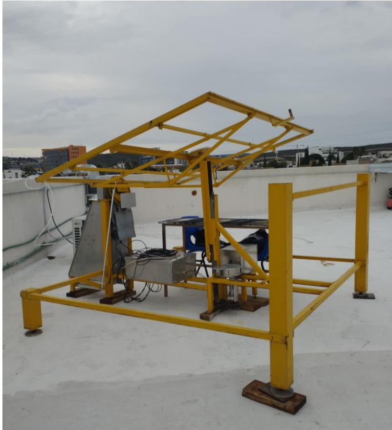
Figura 3.3. Estación de pruebas de paneles solares instalado en el Instituto de Investigación en Comunicación Óptica.
