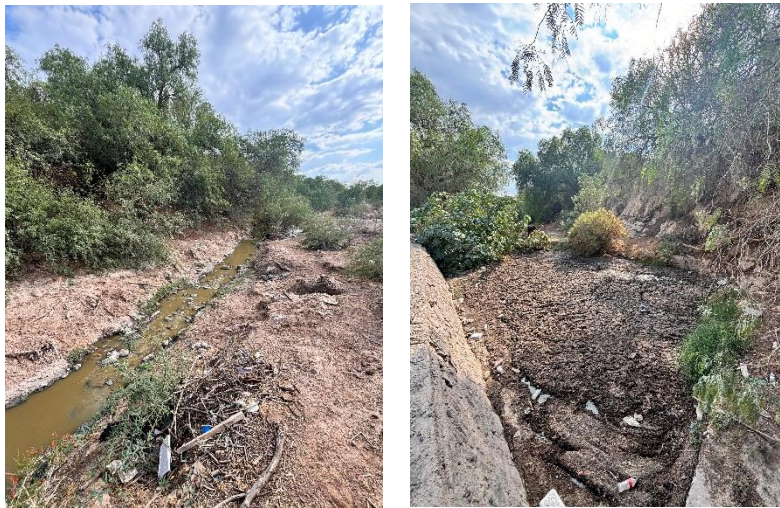
Figura 13. Canal de agua residual en Villa de Zaragoza.
