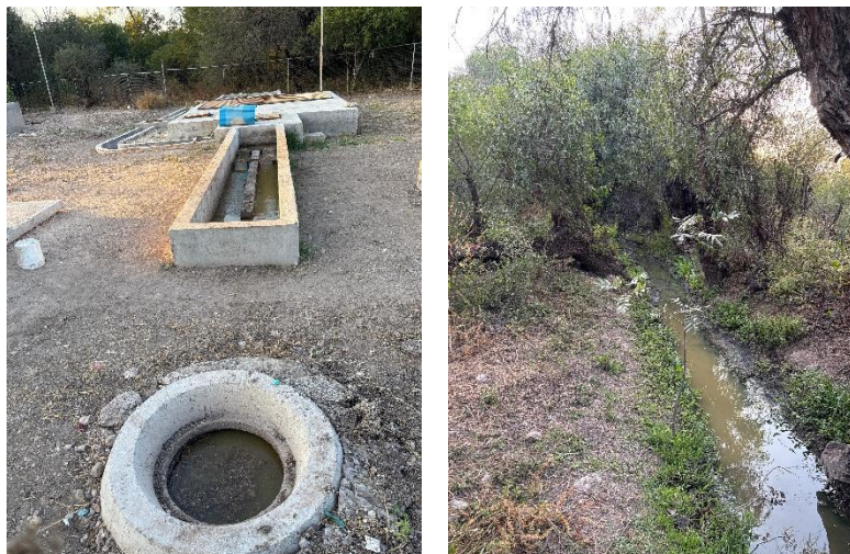
Figura 17. PTAR en la localidad de El Fuerte.
