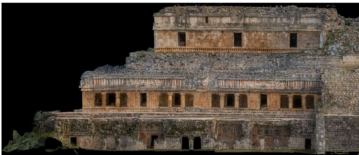
Figura 19. Ala Oeste, fachada Sur del Gran Palacio de Sayil. Fotogrametría realizada por Arqlgo. Benjamín Esqueda. Proyecto Conservación Ruta Puuc (2022-2023).
