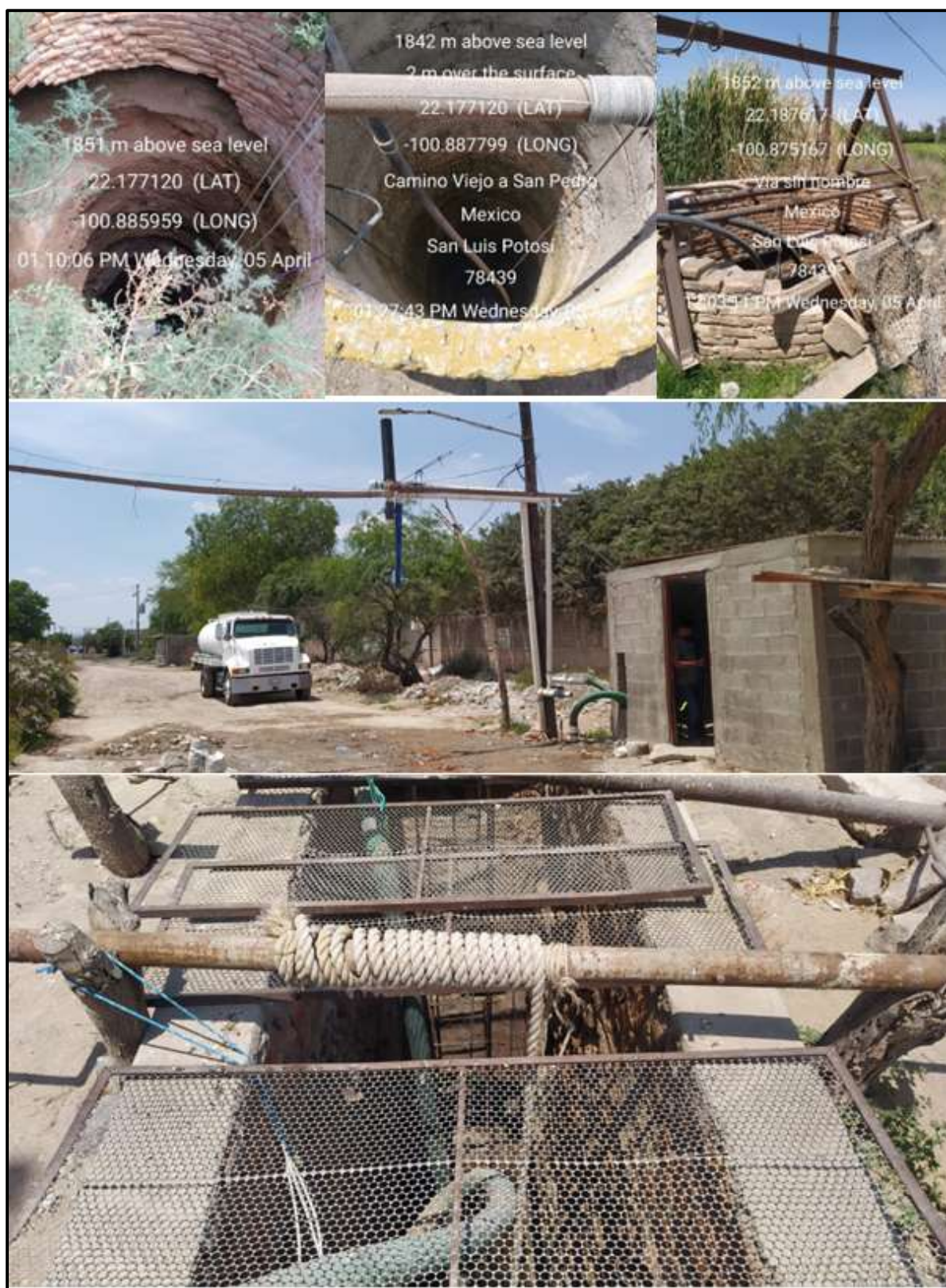
Figura 12.- Levantamiento de pozos poco profundos realizado durante la visita al acuífero somero. Obtención propia.
