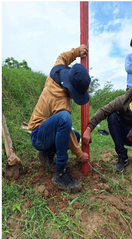
Figura 5. 4 Proceso de instalación de las estaciones limnimétricas
