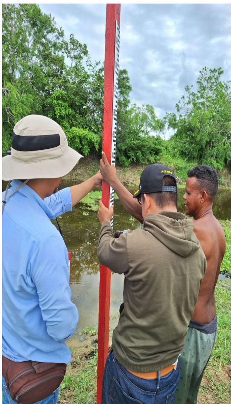
Figura 5. 4 Proceso de instalación de las estaciones limnimétricas
