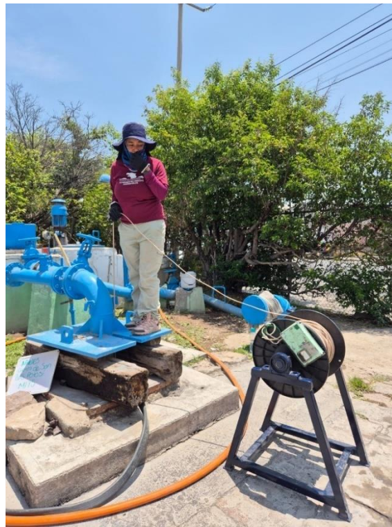
Figura 58. Medición de nivel, con sonda de nivel creada.
